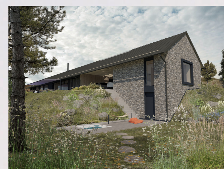
pohled na vejtnínek a obytnou část domu ze spodní zahrady
